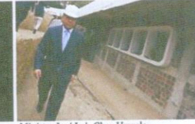
Ministro José Luis Chea Urruela supervisa los trabajos de construcción.
